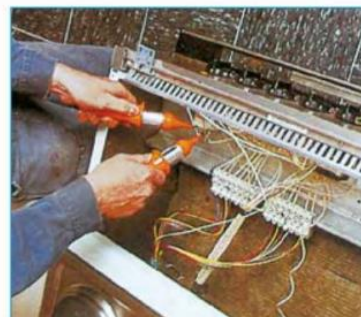
Bild 4: Feststellen der Spannungsfreiheit an einem Elektroherd
