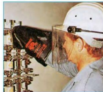
Bild 2: Herausnehmen eines NH-Sicherungseinsatzes
