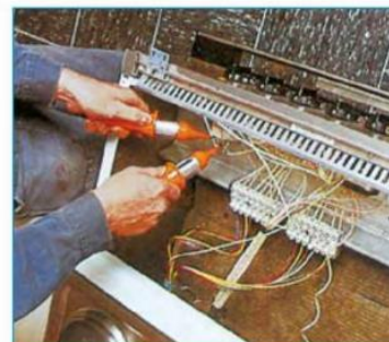
Bild 4: Feststellen der Spannungsfreiheit an einem Elektroherd
