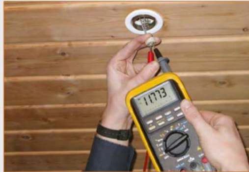
Bild 1: Spannungsmessung an einer Niedervolt-Halogen-Beleuchtungsanlage
